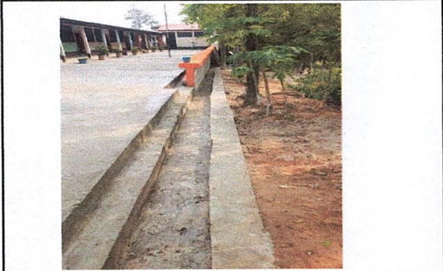
Foto 1: Lugar donde inicia la cuneta de concreto.
