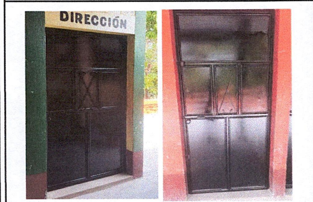
Foto 3: Mantenimiento de puertas finalizado.
