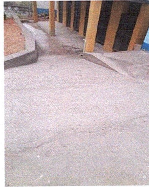
Foto 2: Camino de concreto que conduce a los sanitarios finalizado
