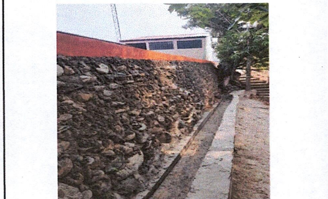
Foto 3: Cuneta debajo del muro de piedras.
