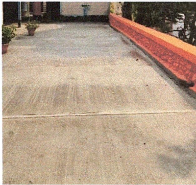
Foto 1: Muro medianero de patio finalizado.
