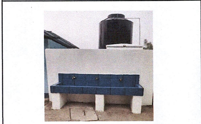
Foto 3: Depósito de agua debidamente pintado.
